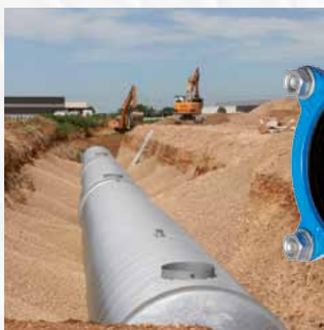
Réservoirs posés en série
